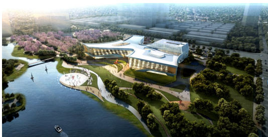
公共文体中心——MUSE(缪斯)国际创意大奖建筑照明专项铂金奖、全国建设工程BIM大赛三等奖、江苏省标准化三星级工地
